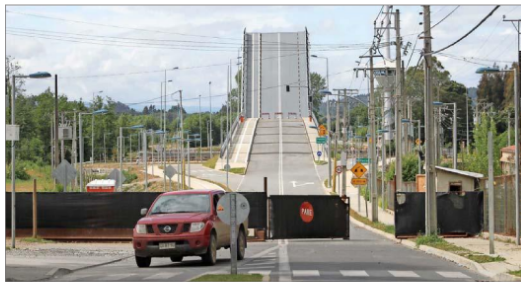
REPARACIÓN.— Las obras de reparación del puente Cau Cau están proyectadas para el 2017, tras el estudio forense presentado por el ministro Alberto Undurraga este año.
